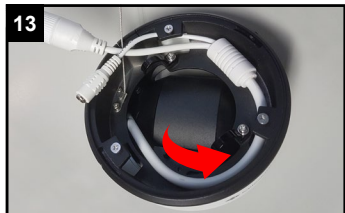
Kabel in in Pfeilrichtung verlegen.
